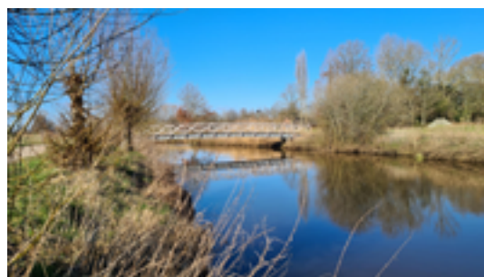
Afbeelding 15: Brug over de Dommel (Bron: Avontuurlijke Wandelingen )
